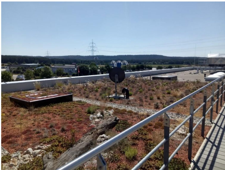
Abbildung 27 Dachaufsicht HTI-Gienger (eigene Aufnahme, 2019)
