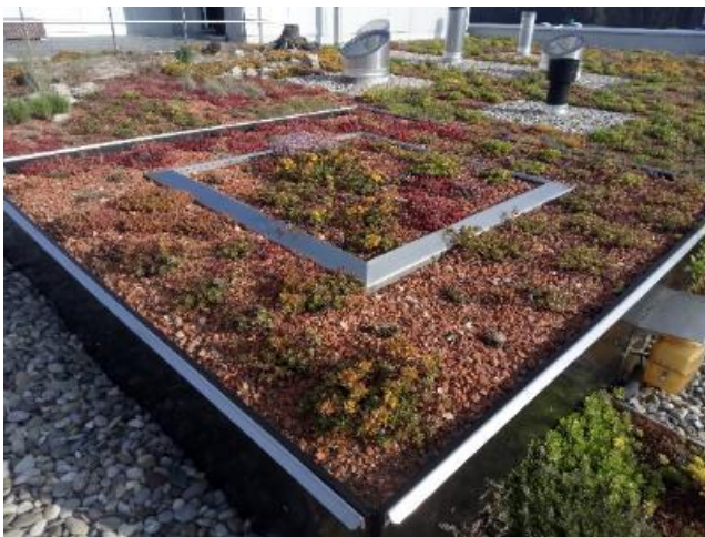
Abbildung 29 guter Zustand des Gründachlysimeters (eigene Aufnahme, 2019)
