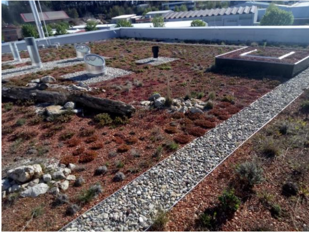
Abbildung 28 Zustand extensive Dachbegrünung (eigene Aufnahme, 2019)
