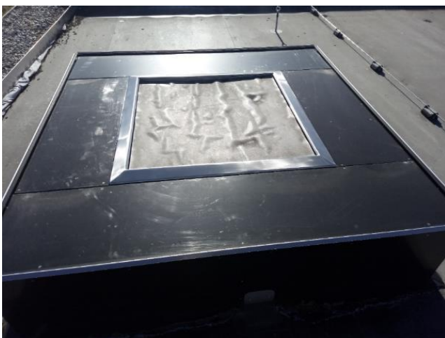
Abbildung 30 Zustand Foliendachlysimeter (eigene Aufnahme, 2019)
